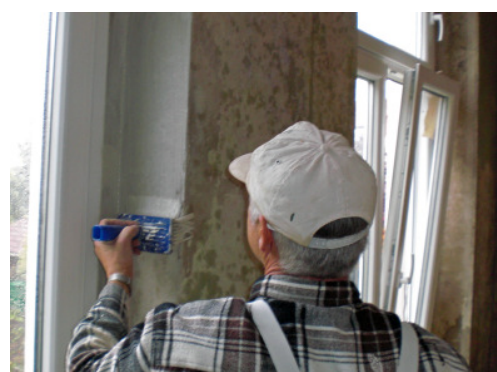
Wärmebrücken bestreichen.
